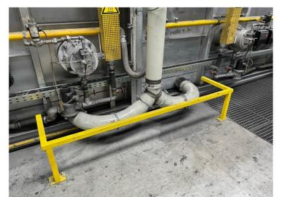
Rammschutz von Bauteilen zum äußeren Maschinenschutz
